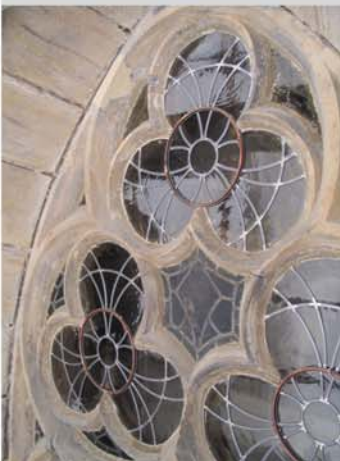
erneuerte/restaurierte Bleiverglasung
