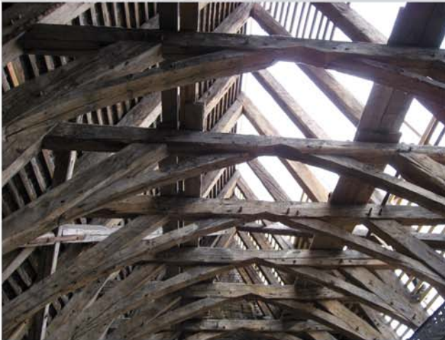
Gotischer Dachstuhl
