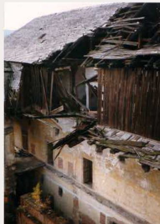
Ansicht von Osten, Vorzustand
