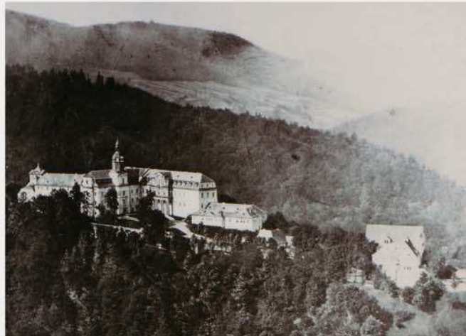
Fotografie Schlossanlage, vor den Umbauarbeiten ab 1940
