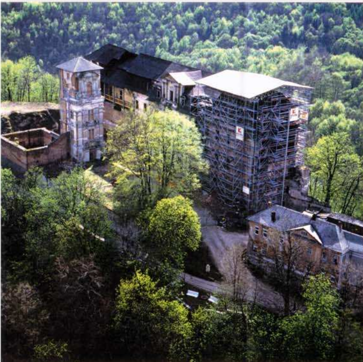
Luftbildaufnahme während der Notsicherungsmaßnahmen, Ansicht von Nord-Osten, 1993
