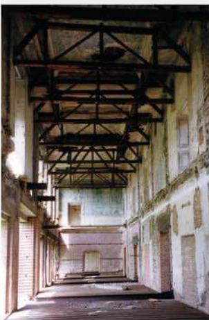
Bestand Hauptgebäude innen
