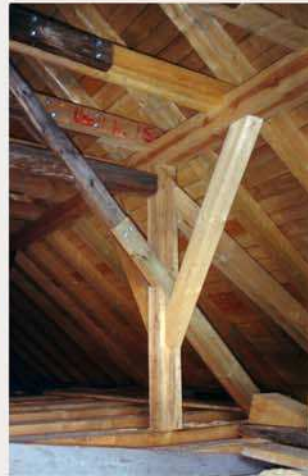
Reparaturverbindung Dach
