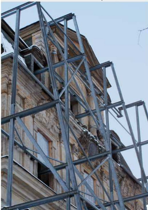
Fassadensicherung Hauptgebäude
