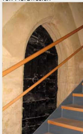
Treppe an der Turmwand
