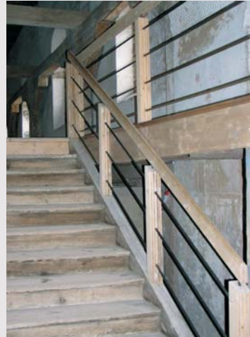
Alte Treppe mit neuem Geländer
