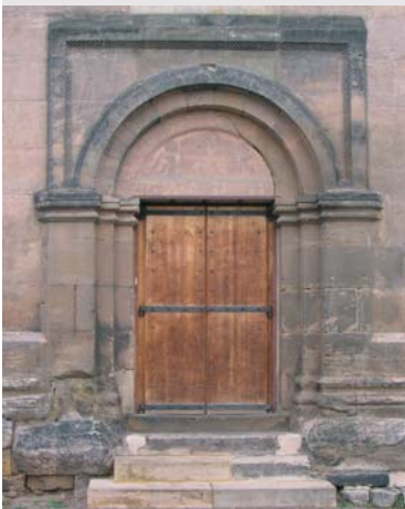
Portal an der Südseite
